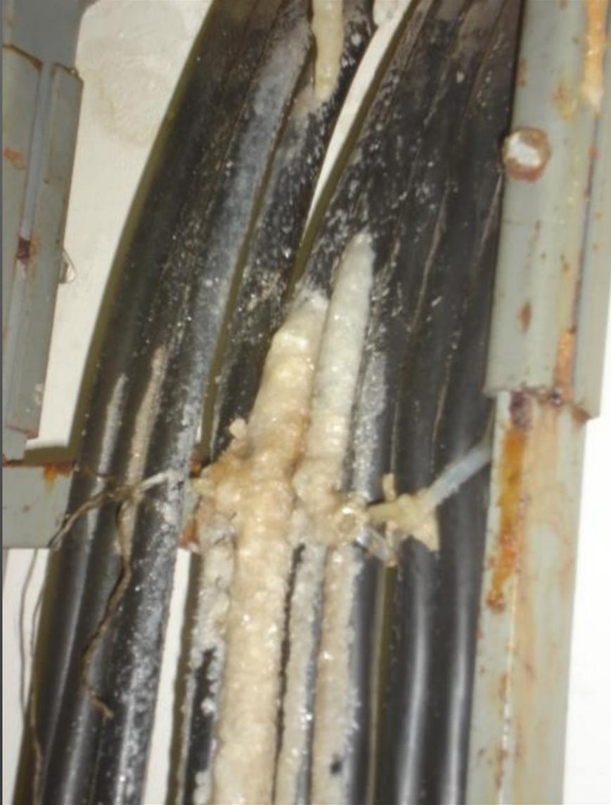
Aspecto superficial com a formação de estalactite salino no leito de cabos mesmo na posição vertical, superfície aquecida, numa subestação elétrica de bombeamento em Copacabana no Rio de Janeiro.
