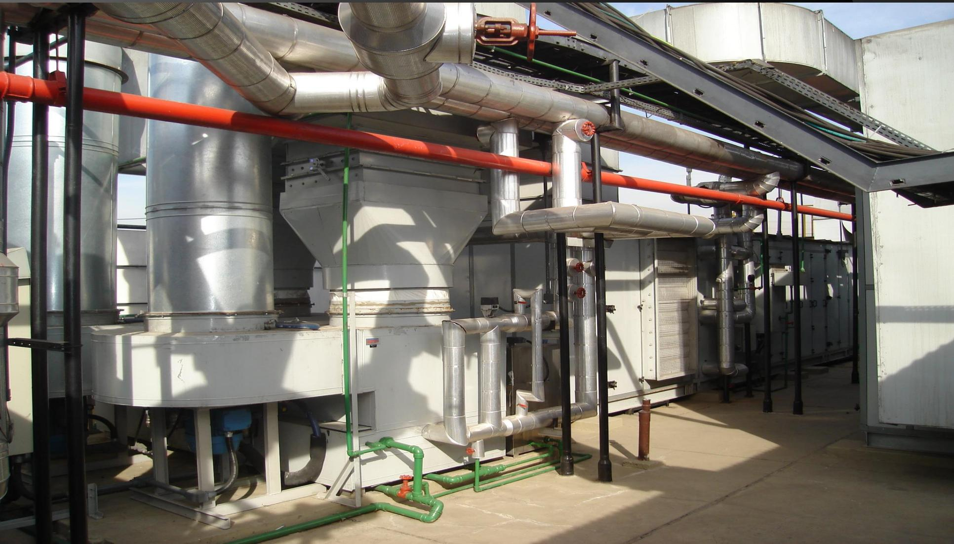
Nesta versão refrigerada o depurador centrífugo multiventuri opera com circuito de água gelada em serpentina imersa que refrigera a água re-circulante, de forma a podermos **controlar a incorporação de umidade no ar por evaporação de líquido**, ou seja, temos um processo de **depuração físico-químico-biológico** com simultânea refrigeração para impedir fluxos indesejáveis de energia que provoquem a vaporização da água elevando a umidade.
